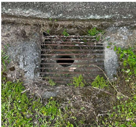
Imagem 03 – Caixa de captação existente
